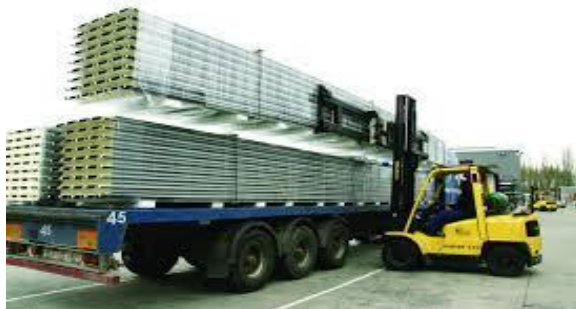
przykład rozładunku płyt wózkiem widłowym)
